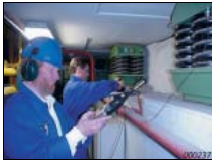
Abb. 3 Anwendung von FFT bei der Untersuchung der Schwingungsisolierung in einem großen Kraftwerk
