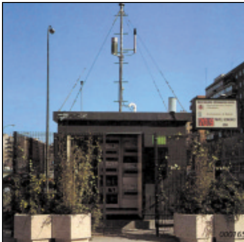
Stazione di monitoraggio permanente a Madrid
